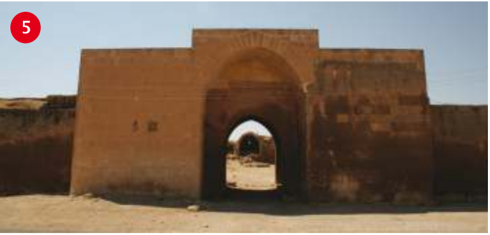
HAN EL-BARUR (KERVANSARAYI) Harran'a 26 km. uzaklıkta Göktaş Köyü'nde bulunan yapı, Eyyubiler Dönemi'ne (Miladi1219) tarihlenmektedir. "Barur", Arapça'da "Keçi gübresi" demektir. Rivâyete göre, hani yapıtiran İsa oğlu İmad oğlu Hacı Hüsameddin Ali Bey, burayı kuru üzümle doldurmuş, yoldan geçen veya kervansarayda konaklayan misafirlere ikram edermiş, "Benzen sonra gelenler burayı keçi gübresi ile dolduracaklardır" demiştir. Yapı, Moğol istilasından sonra harap olmuş ve yerli halk tarafından uzun yıllar ahır olarak kullanılmıştır.
